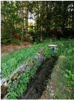
Drain sous chemin
